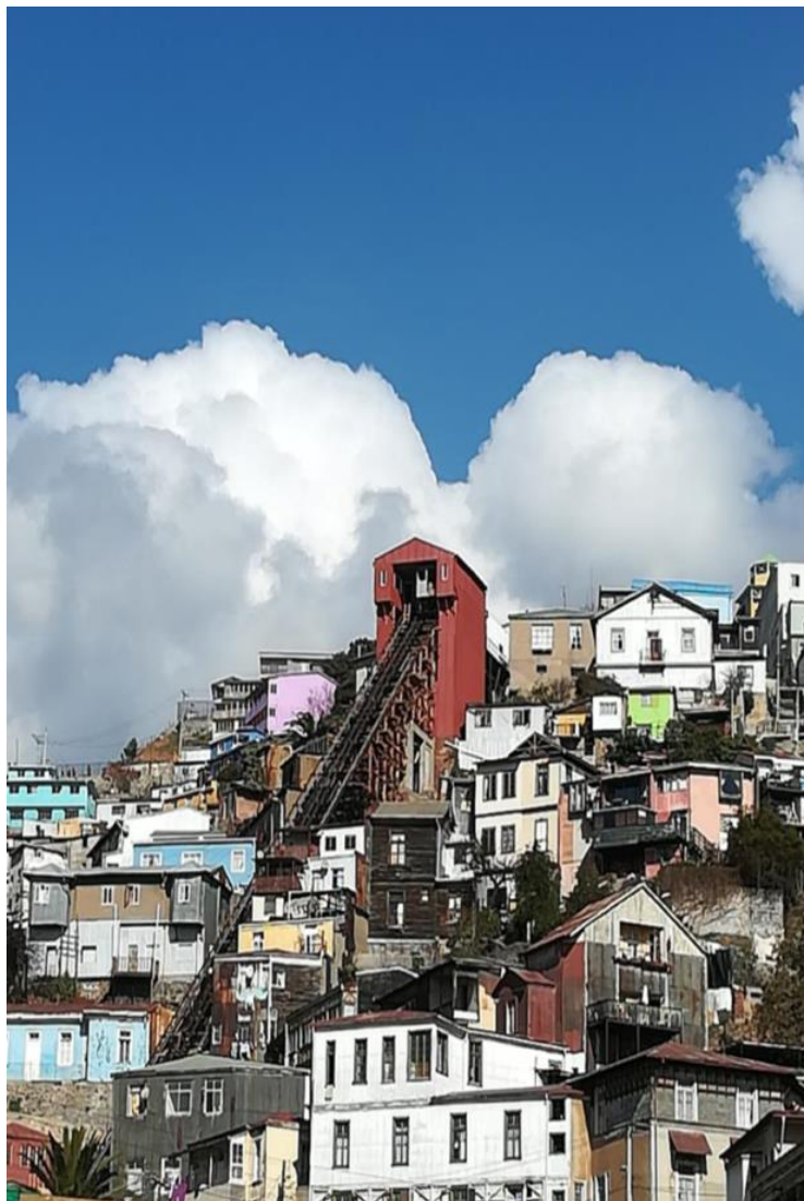
Estación superior y plano de rodadura.
