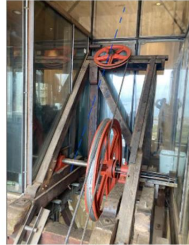
Verificación de Paralelismo de sistema poleas y cables respecto al Plano de rodadura
