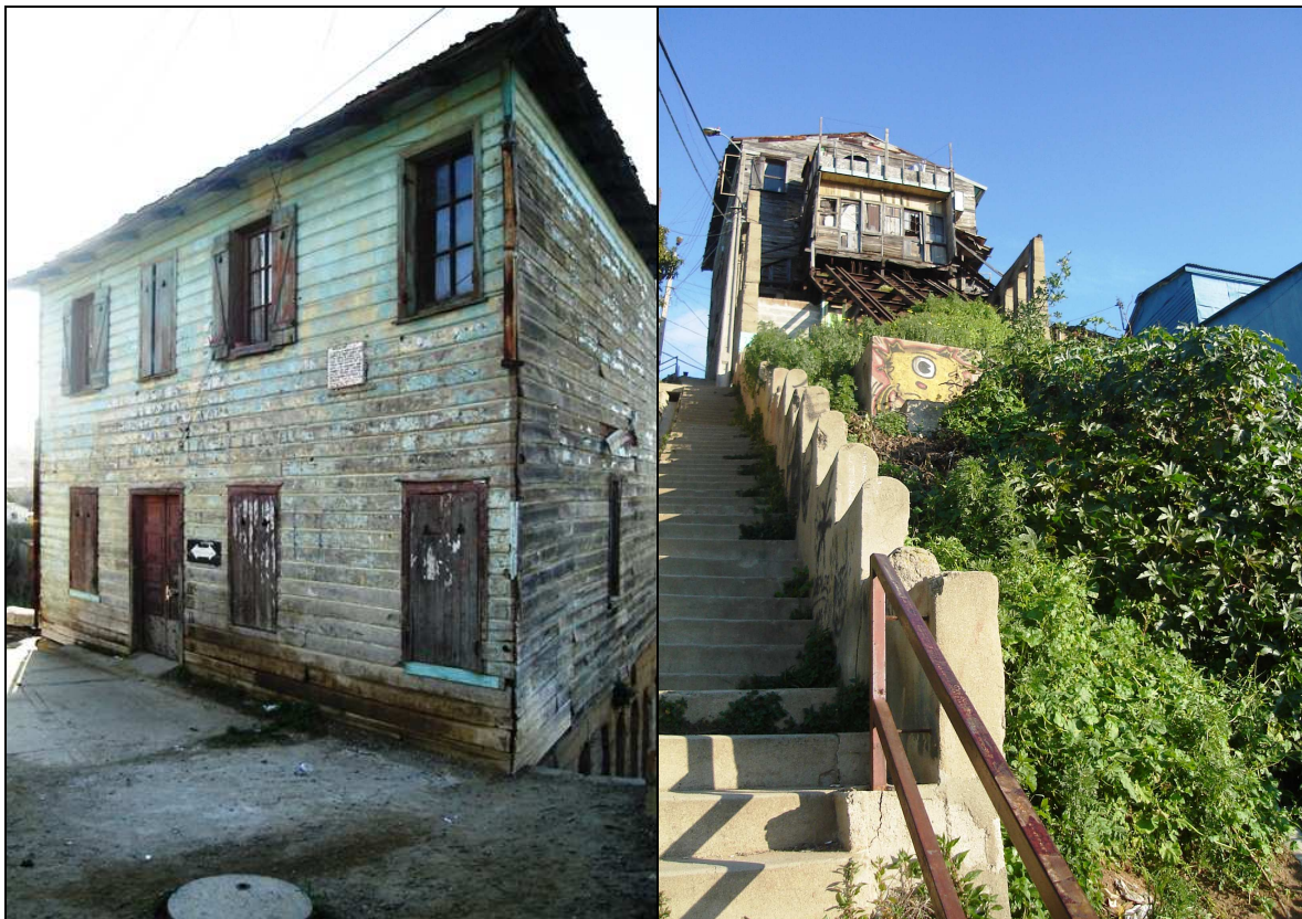
Imagen 3: Estado Actual Ascensor Cerro Las Cañas Fuente Fotografías: Elaboración Propia
