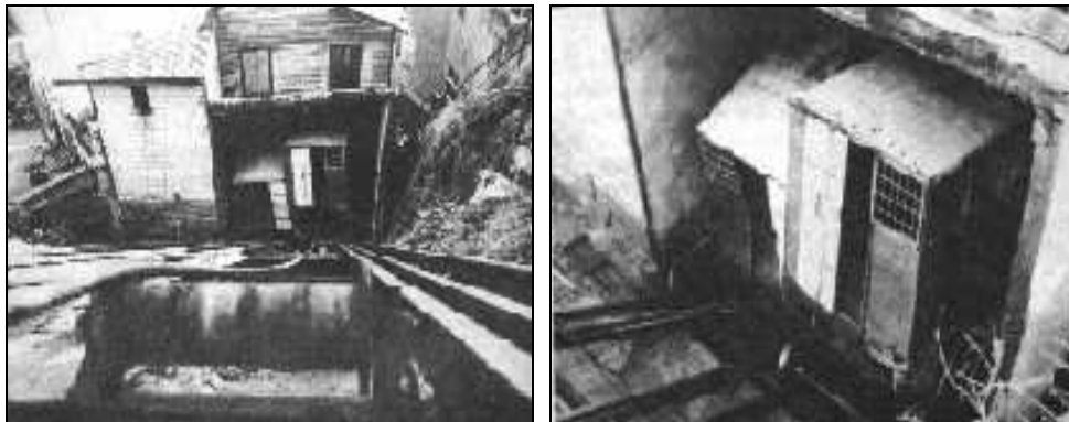
Imagen 1: Accidente Ascensor Cerro Las Cañas. Fuente Fotografías: www.ascensoresvalparaiso.tk
