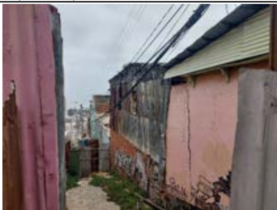
Importante desplome de la fachada hacia calle Bari 23/11/2023
