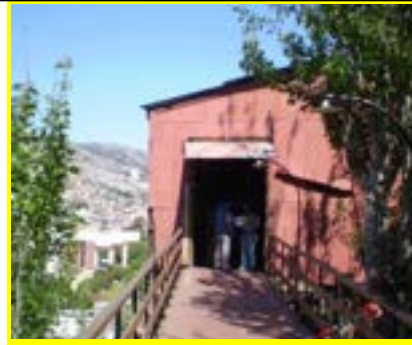
Entrada estación alta año 2009.
