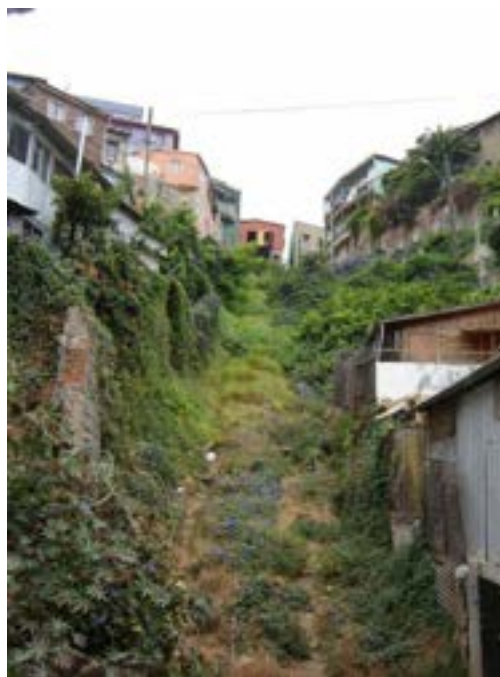
Estado de la ladera del terreno, año 2011
