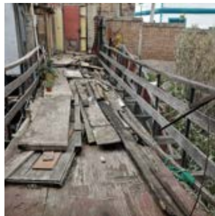
Puente acceso estación alta año 2023
