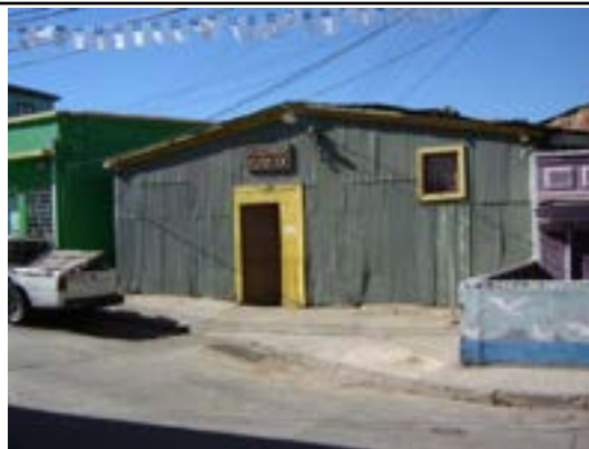
Imagen 7 Estado del ascensor, año 2009.
